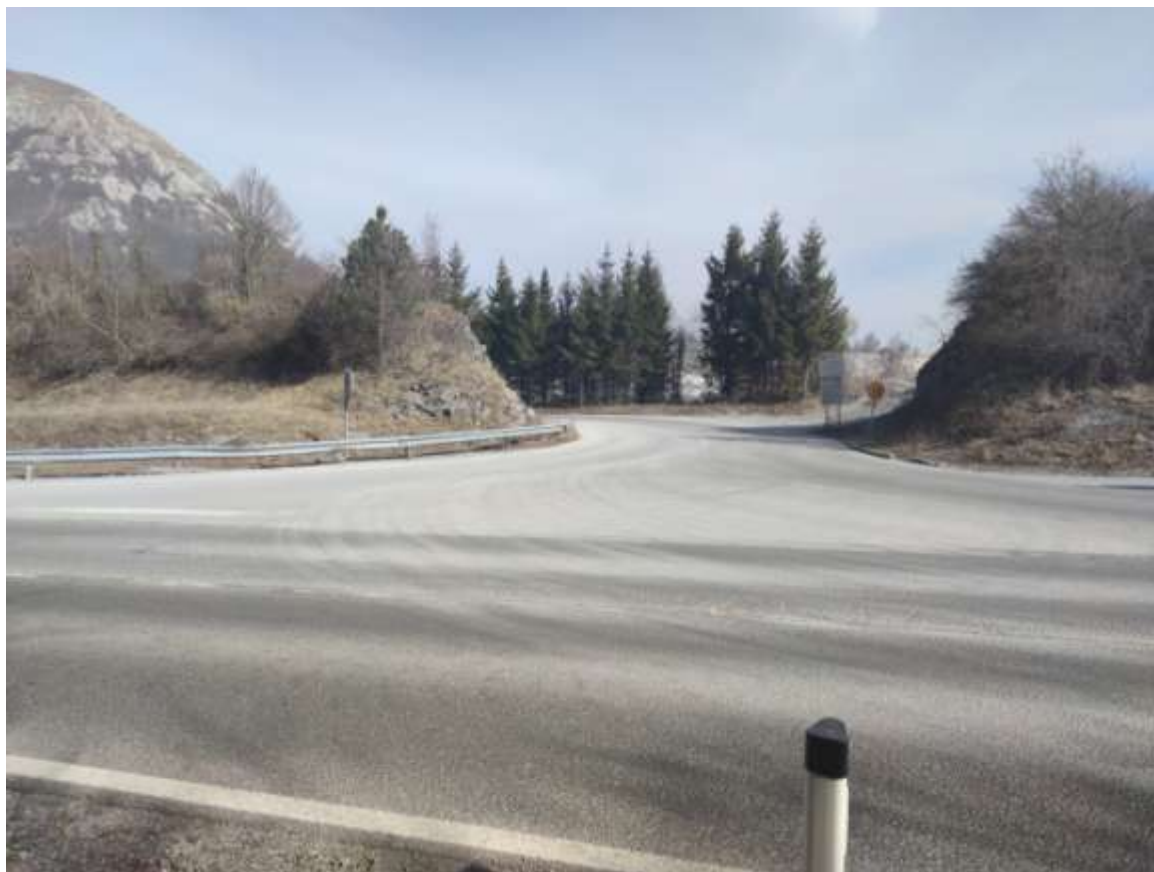
Sliki 4.E.5.1 in 4.E.5.2: Razdrto – Priključek na glavno cesto in območje kamnoloma
