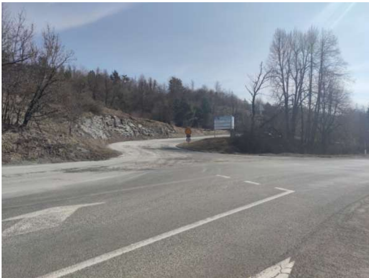
Sliki 4.F.5.1 in 4.F.5.2: Laže – Priključek na glavno cesto in oprema kamnoloma
