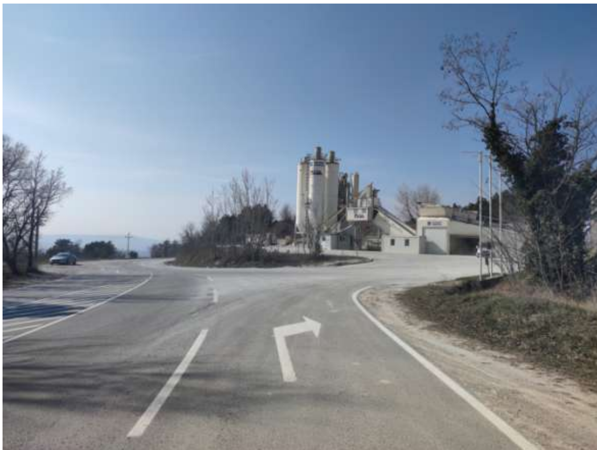
Sliki 4.C.5.1 in 4.C.5.2: Črni kal – Čnotiče – Priključek na glavno cesto in vhod v kamnolom
